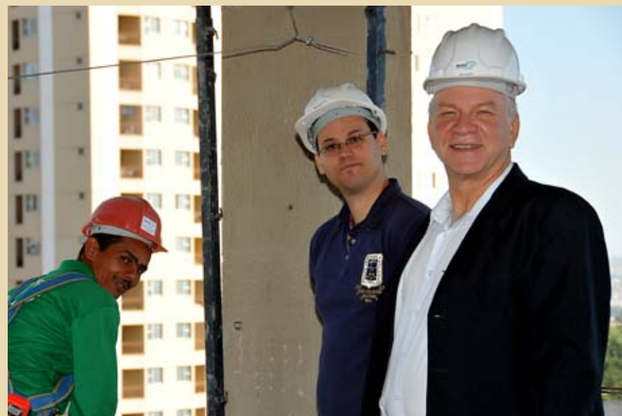
Engenheiros Wesley Galvão e Ricardo Faria inspecionam itens de segurança nas obras
